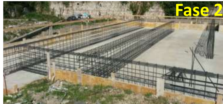
Armatatura delle travi in calcestruzzo
