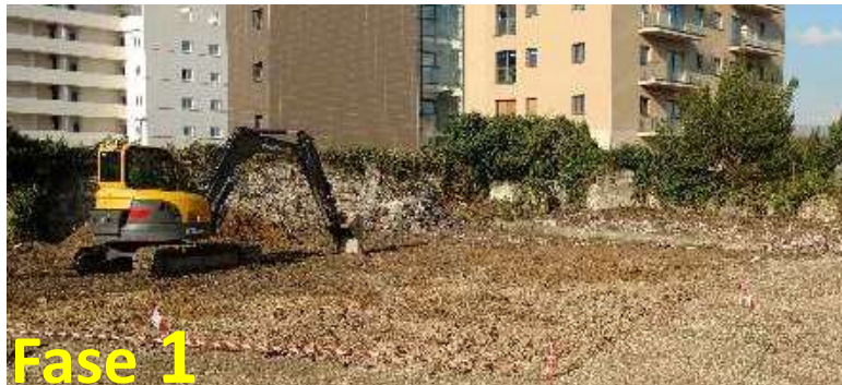
Scavo per fondazioni
